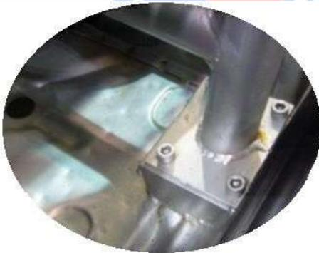
**Fijación atornillada mediante pie de anclaje con placa de refuerzo en forma de cajón**
